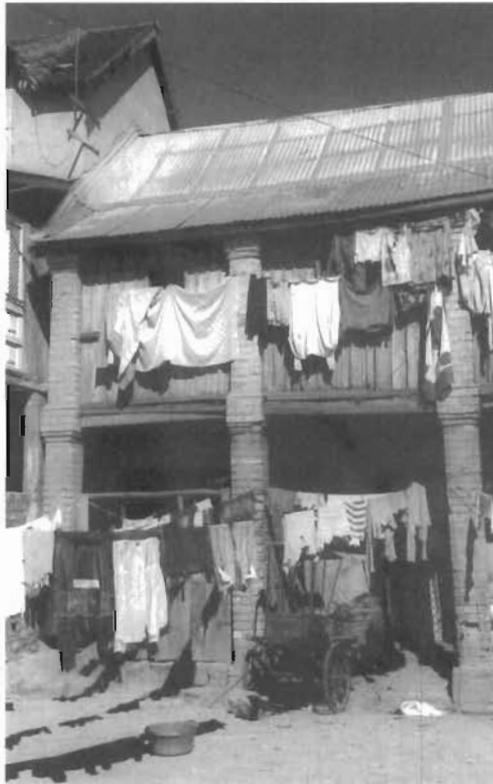
*Photo 4 : Exemple de substitution de la tôle à la tuile sur des maisons traditionnelles
