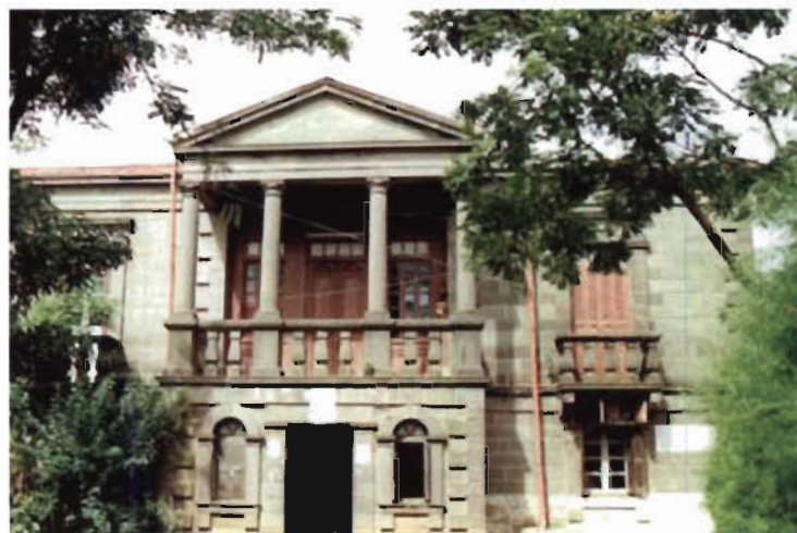
Addis Abeba, Résidence ayant appartenu à M. Karacacyan, dentiste de Ménélik II. Elle est construite dans un style européen avec colonnes et fronton. (© ORAAMP, 2002)
