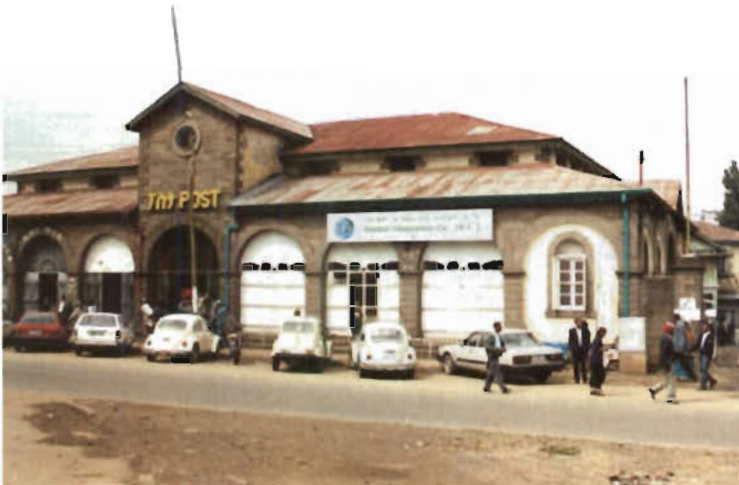
Résidence de Muhamed Ali: bâtiment rassemblant différentes influences et époques mais qui est souvent cité comme rappelant les premières architectures des bâtiments publics à Addis-Abeba. Cette résidence est aussi nommée « ancienne poste », fonction dont elle a été rapidement investie. (© ORAAMP, 2002)
