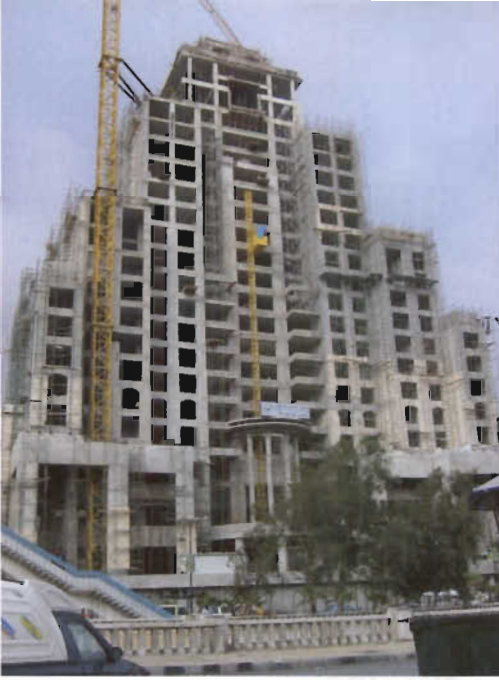
Le chantier d'un hôtel de luxe, 2004. (© Carine Sabbagh, 2004)
