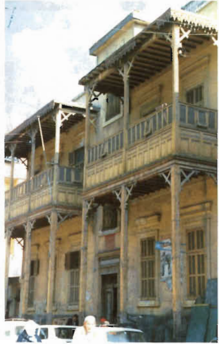
Quartier européen, maisons jumelles avec galerie en bois. (© Sawsan Noweir, 1994)
