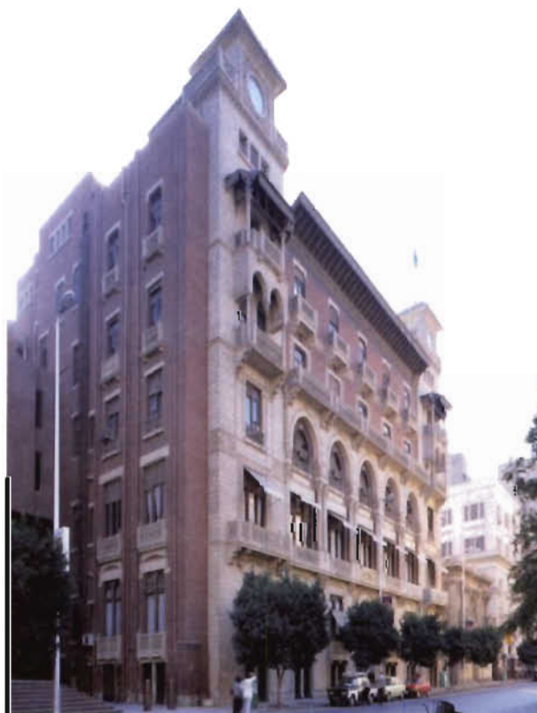
Le Caire, La Banque Misr, rue Mahamed Farid, 1927, Arch. Antonio Lasciac. (© A. Bonnamy, 2000)
