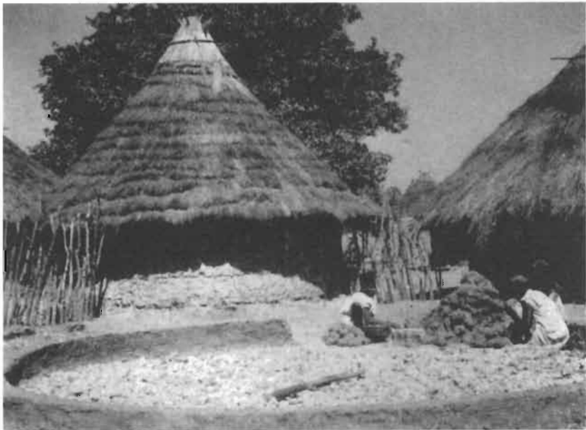
Photot 6 – Construction d'une case. Au premier plan, le mur d'une case en pâte de banco tassé (© E. Bernus, 1956)
