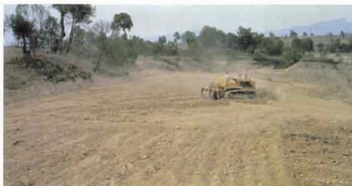
D éfonçage du tepetate par passage croisé de sous-soleuse à dent (ripper).
