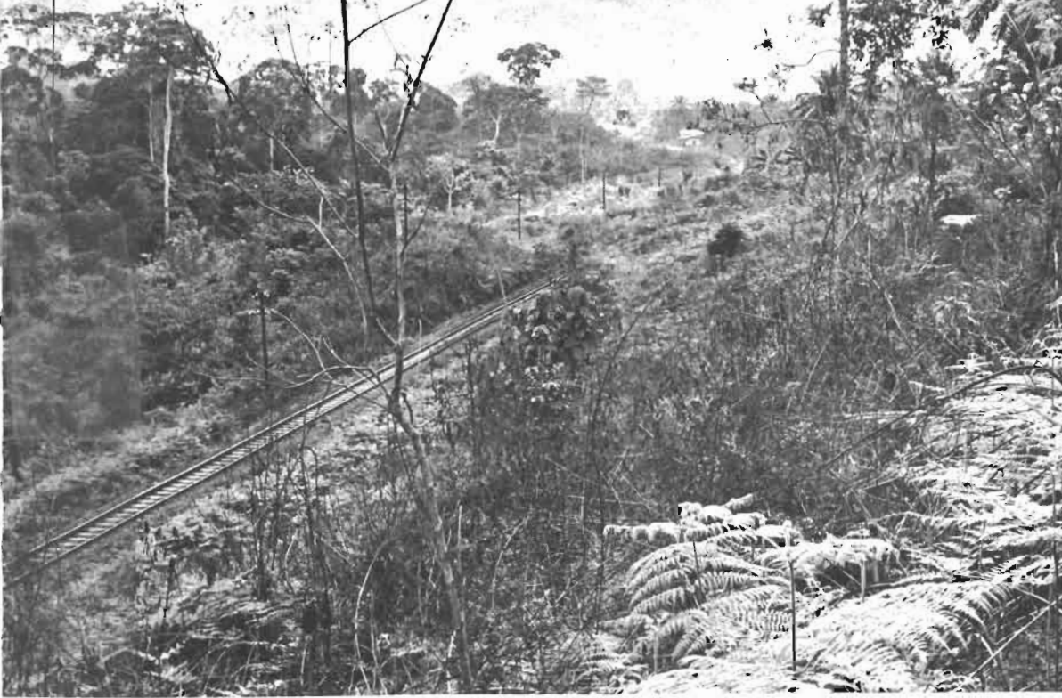
Рн. 43. — Mom (Cameroun) . Vue vers la gare. (Cliché J. Champaud)
