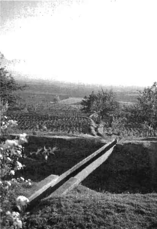
**16** L'eau passe au-dessus du canal du PPI par un pont-aqueduc, traverse les cultures pluviales, puis irrigue les rizières situées en contrebas.
