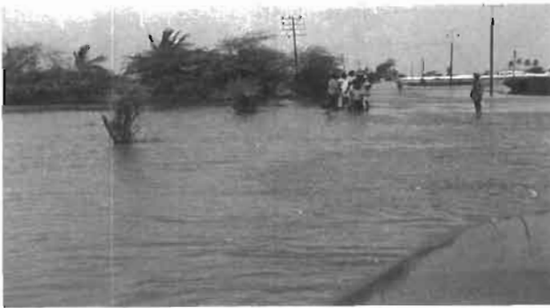
Photo 2 Dernière grande inondation à Saint-Louis en 1950.
