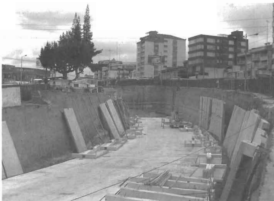
Figura 6 – Construcción de un intercambio vial en la unión de las avenidas América y Naciones Unidas
