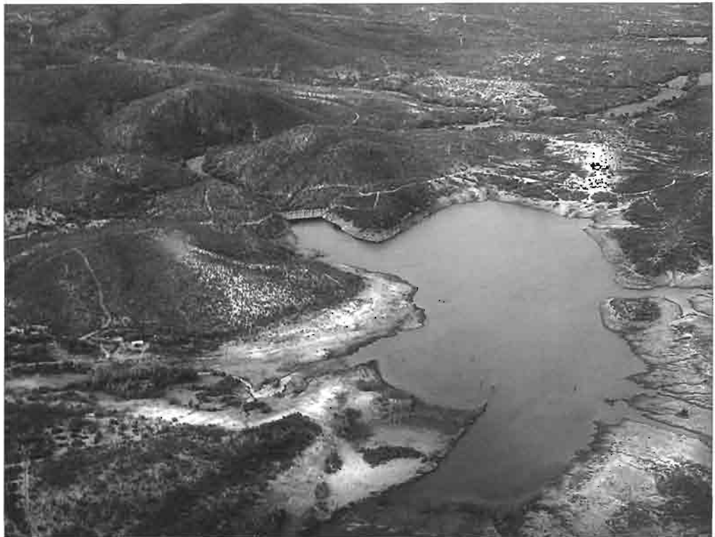
Barrage La Hacienda sur le río Matapé (État de Sonora).
