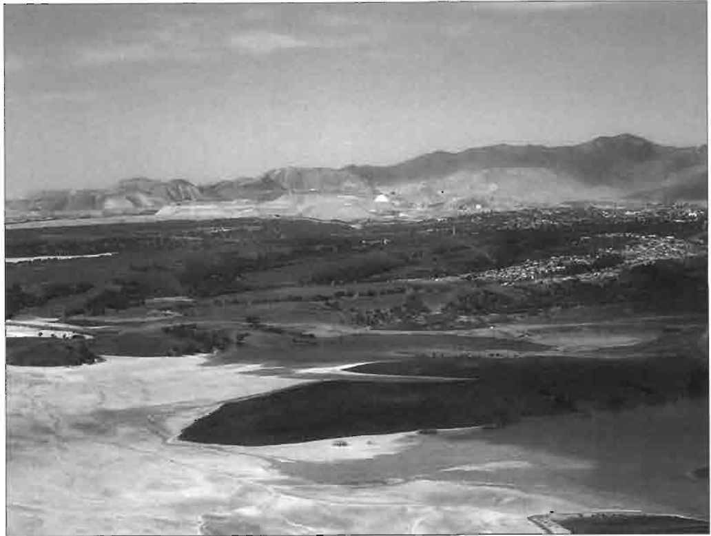
Mine de cuivre à ciel ouvert de Cananea, au nord de l'État de Sonora ; au premier plan, le bassin de décantation des déchets.
