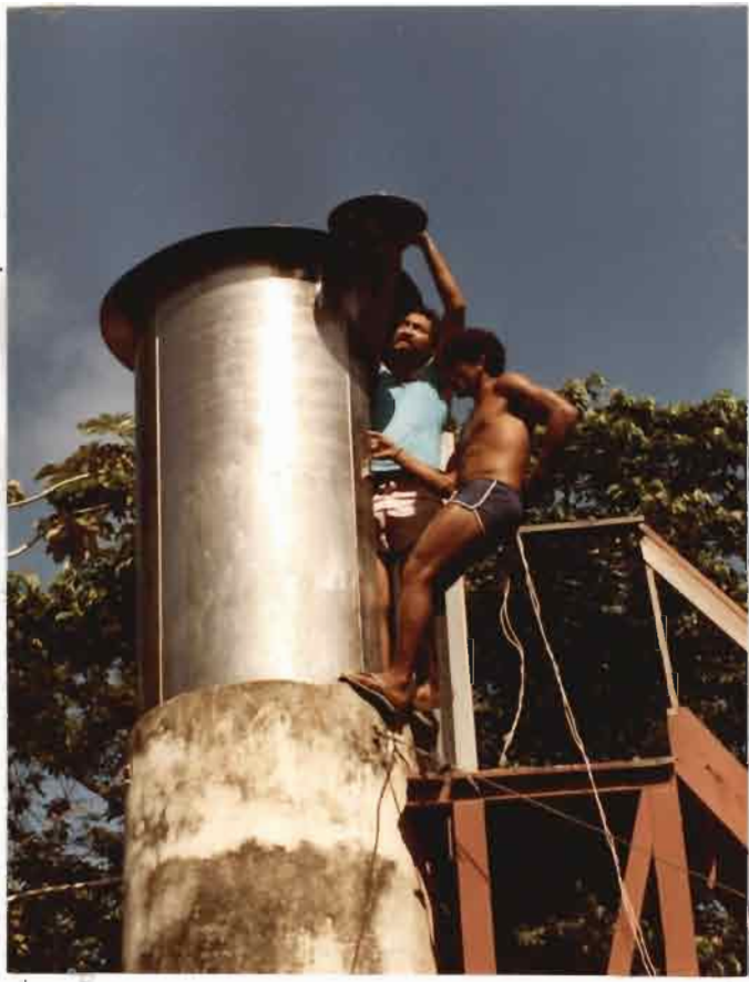
Figura 6: Instalação da baliza (antena) posto de São Francisco
