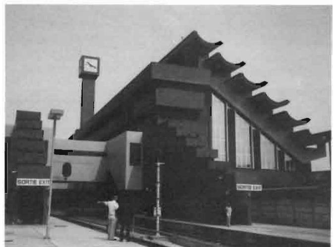
Cameroun. Les quais de la gare de Douala-Bessengué.
