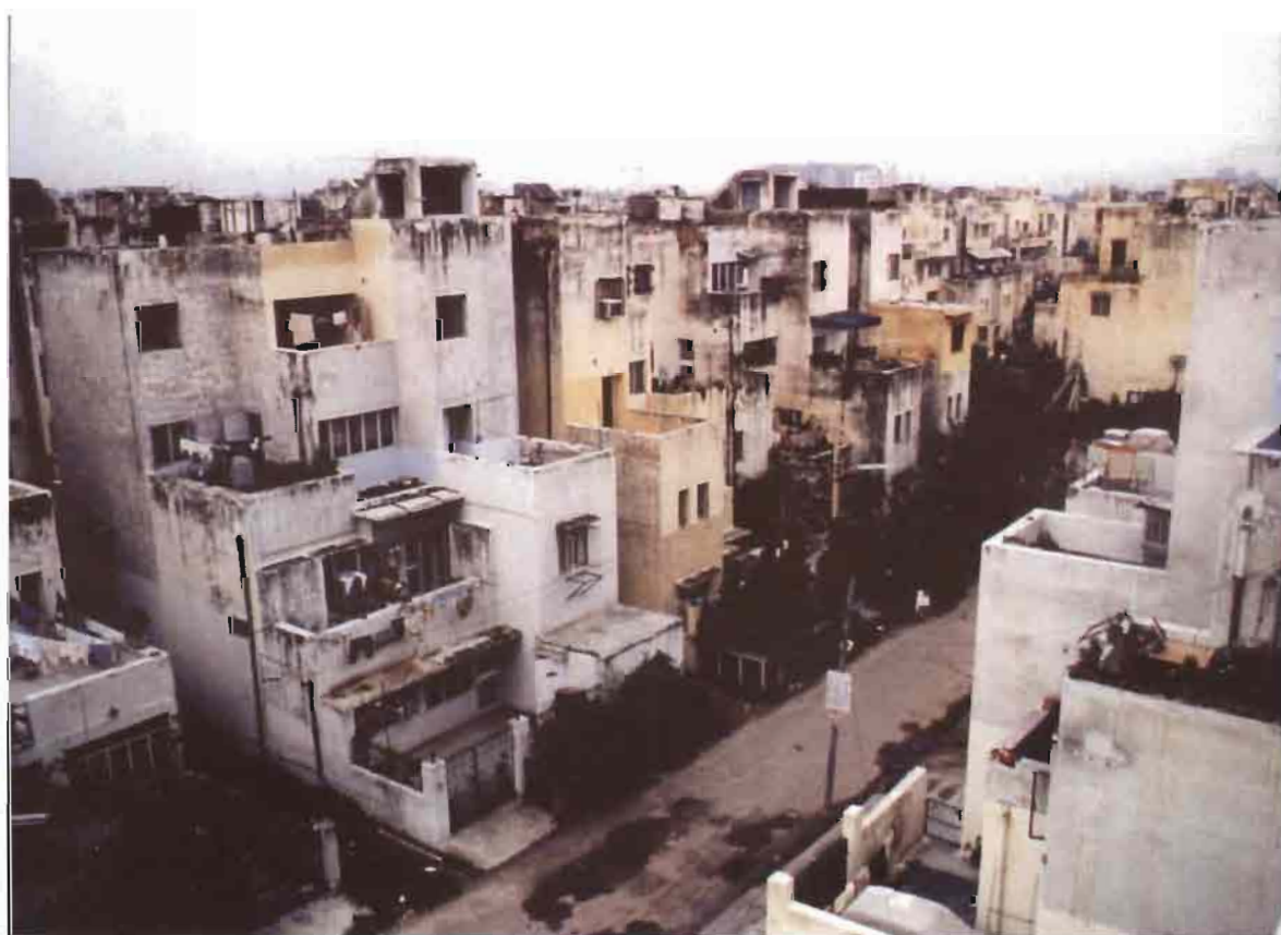
Les DDA flats de Delhi : immeubles collectifs construits dans les années quatre-vingt par la Delhi Development Authority à Mayapuri Vihar, un quartier périphérique dans l'est de Delhi. (cliché : Surendra Rajan, 1995)
