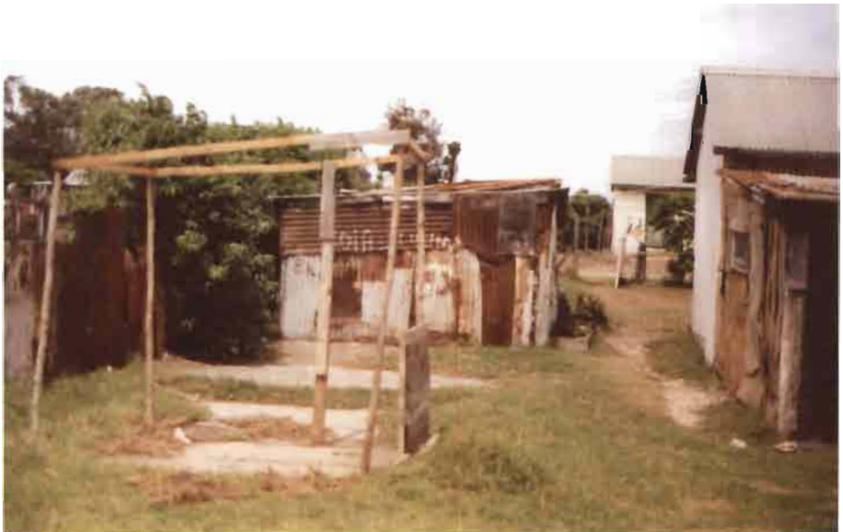
Port-Elizabeth. La vitalité de la construction de backyard shacks dans Walmer Location. (cliché: Marianne Morange, août 1998)
