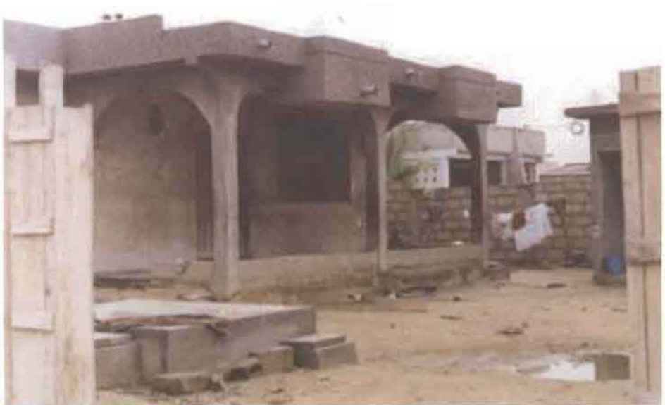
Accra: devenir propriétaire individualisé: la construction au prix fort d'un émigré international à New Gbawe, nouveau front périurbain à l'ouest d'Accra, d'abord occupée à titre gratuit par le ménage d'un gardien. Le compteur électrique est déjà visible.
