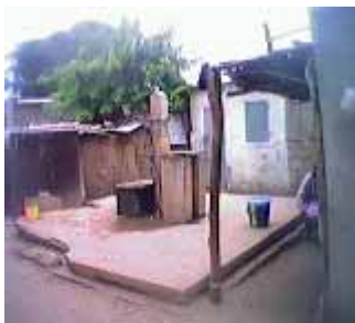
Une borne d'eau extérieure
