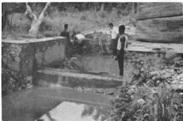
Vue générale du déversoir et de la fosse à sable.
