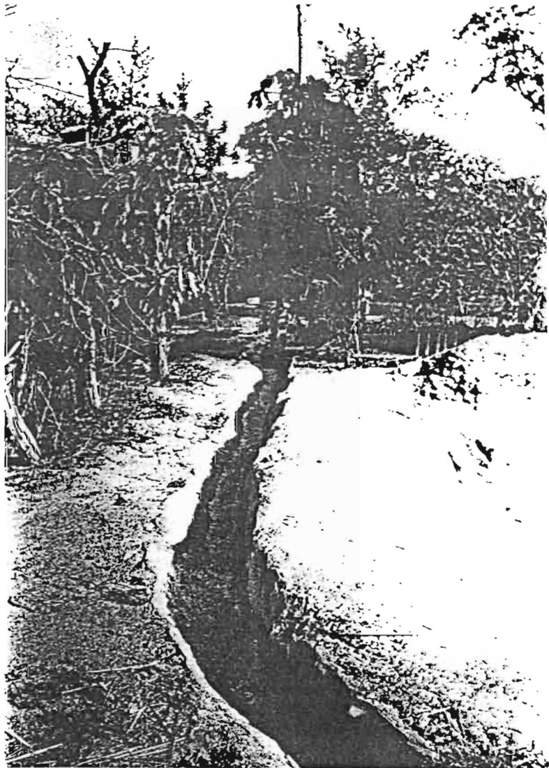
Canal de transmission d'eau entre le puits et le collecteur central
