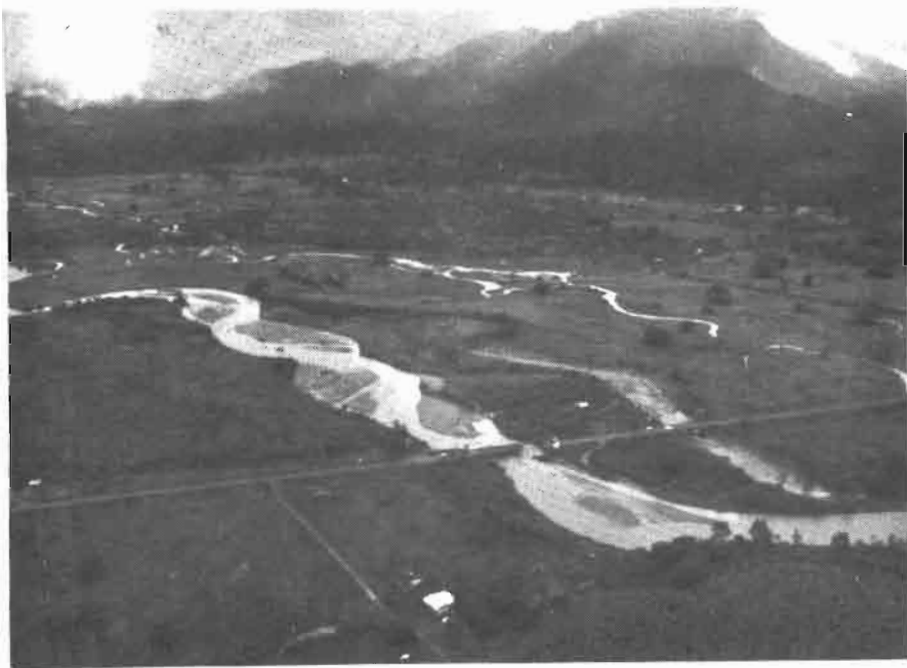
Foto No. 2. Efectos de las inundaciones sobre la infraestructura vial.
