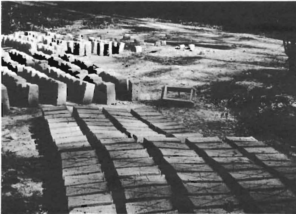
Photo 42 - Fabrication de briques adobes (briques sèches)
