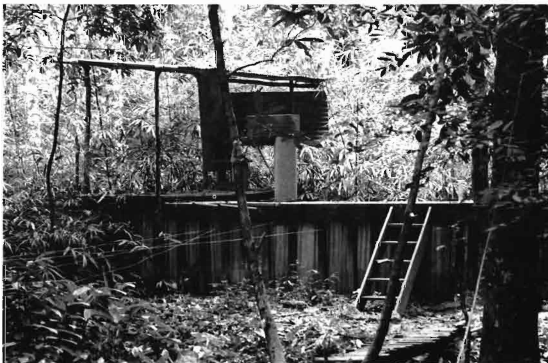
Photo 3. La station de jaugeage aménagée du bassin n° 2 ; vue extérieure du chenal d'écoulement avec accès à la plateforme de lecture
