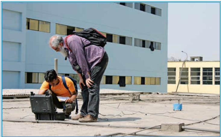
Foto 1: Toma de medida en el techo del Hospital Dos de Mayo – J. Chraibi, 2010
