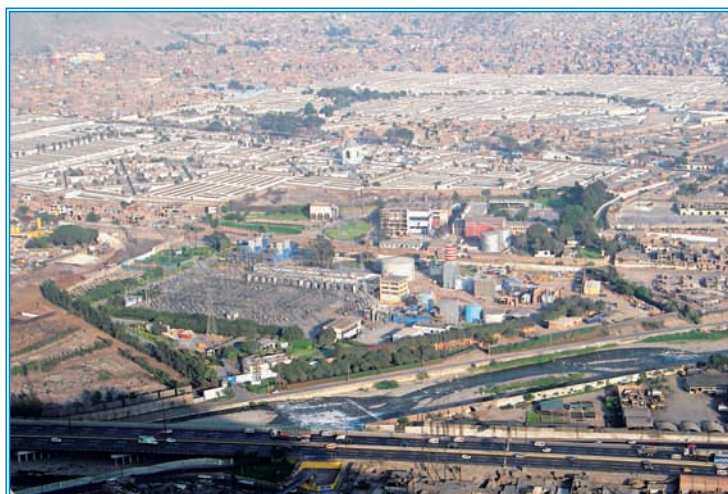
Foto 13: Subestación de transformación eléctrica (El Agustino) – J. Robert, 2010.
