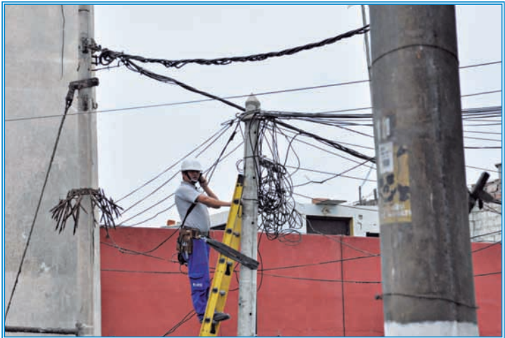
Foto 20: Mantenimiento de la red de telefonía – J. Chraibi, 2010
