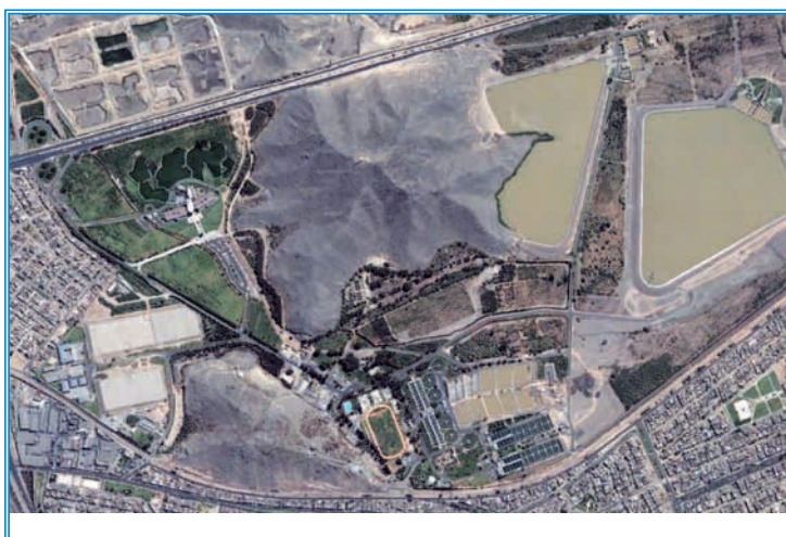
Foto 5: Planta de tratamiento de agua potable de La Atarjea (El Agustino) – Imagen QuickBird, 2006
