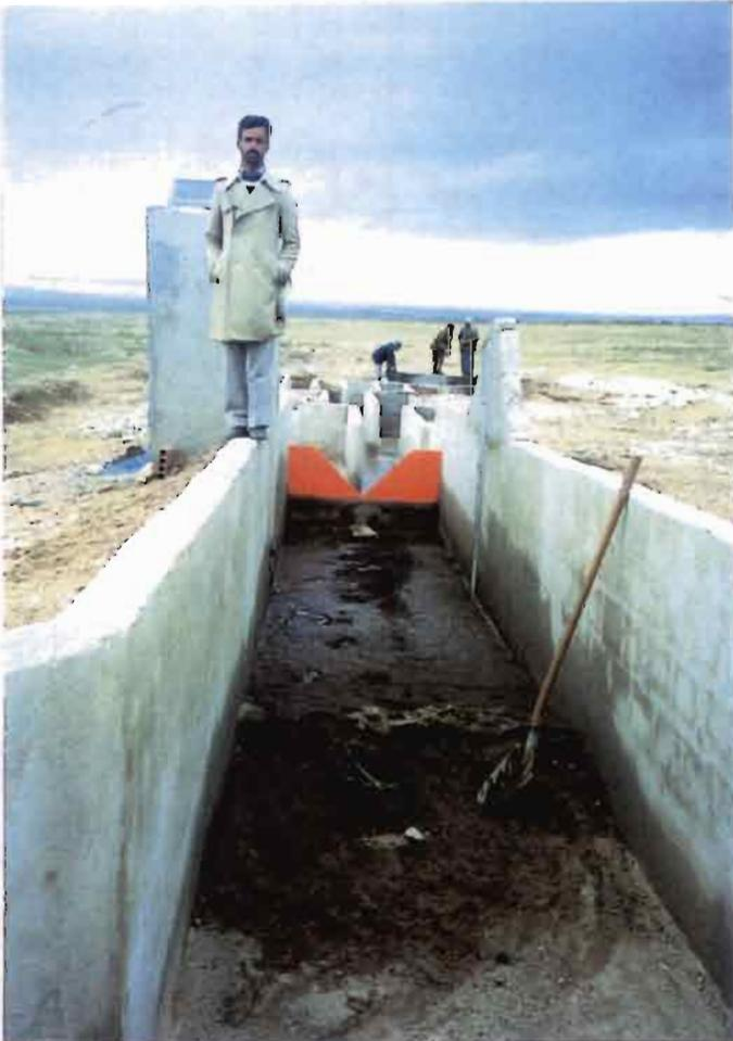
Chaffai 2 - Canal d'aménée des eaux avec dépôts de limons en amont du déversoir en V.
