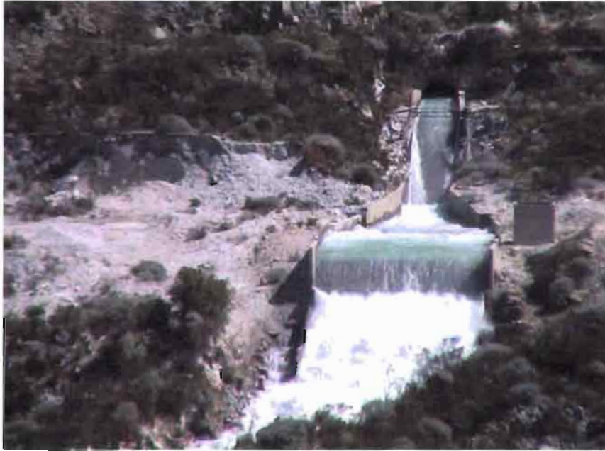
• Foto 6.8. vertedero a pared gruesa del túnel Parón (B.Pouyaud).
