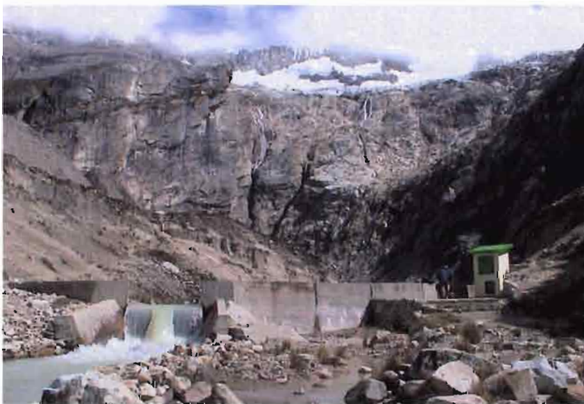
• Foto 6.18. La estación hidrológica de Artesoncocha, 4300 m (B.Pouyaud).
