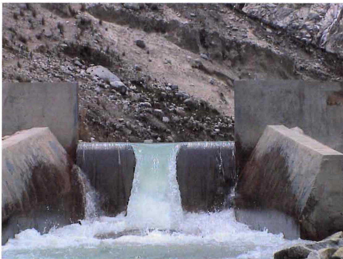
• Foto 6.11. El vertedero compuesto de Artesoncocha, Perú. (B.Pouyaud)
