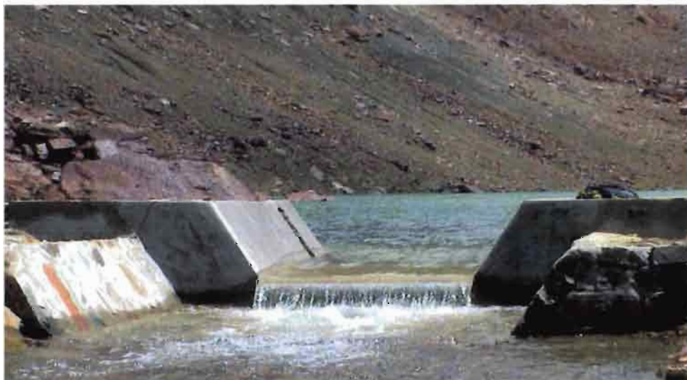
• Foto 6.12. El vertedero auto-aforador de Yanamarey (B. Pouyaud)
