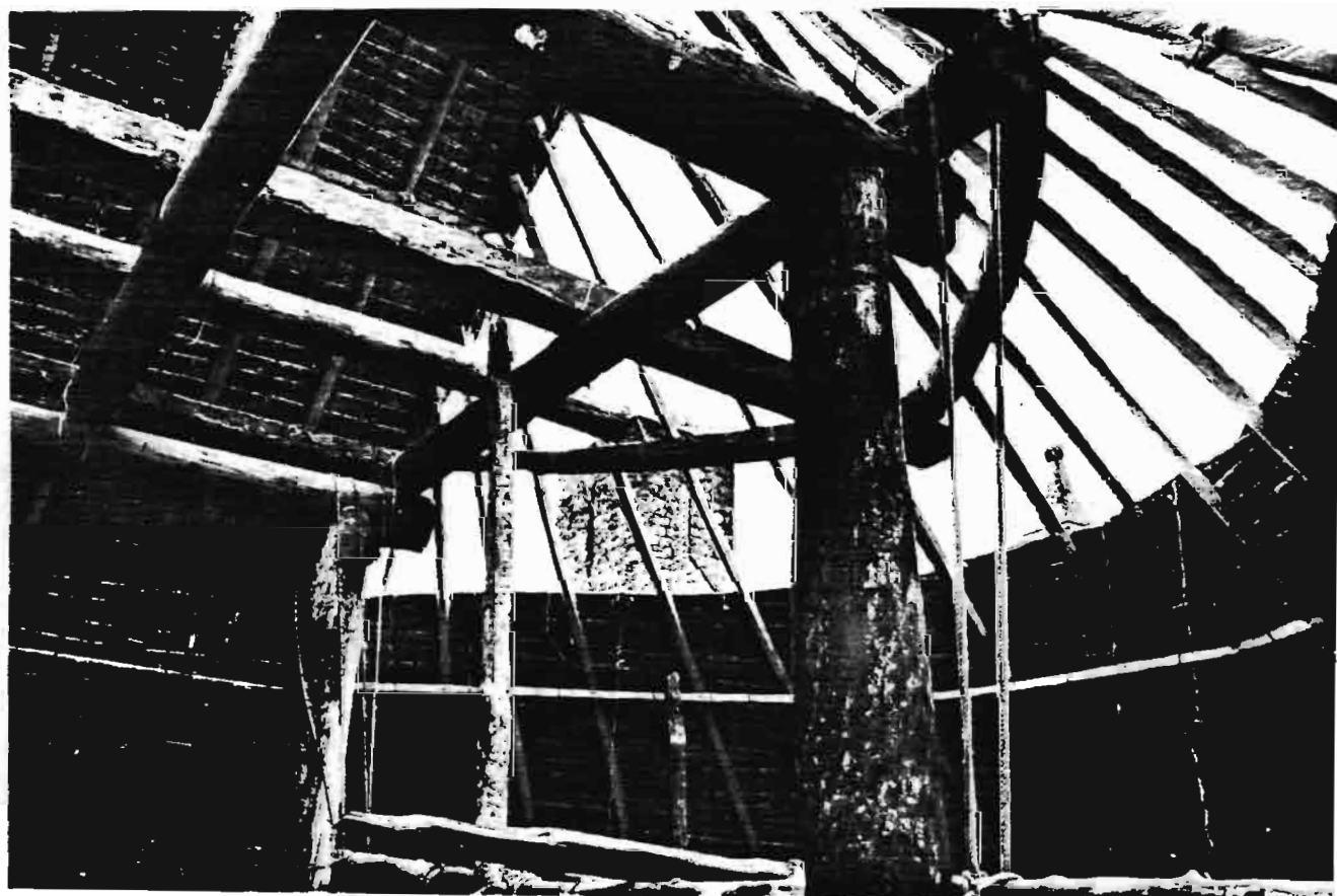
Pou matagi - Le dispositif intérieur de la charpente
