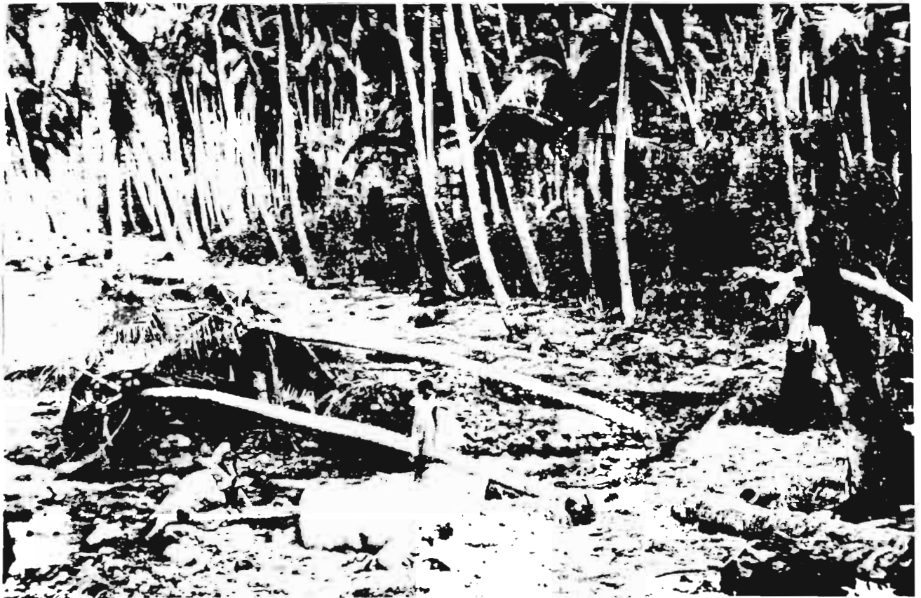
Destruction d'un pont-radier au débouché d'un cours d'eau - Route littorale SIGAVE-FUTUNA
