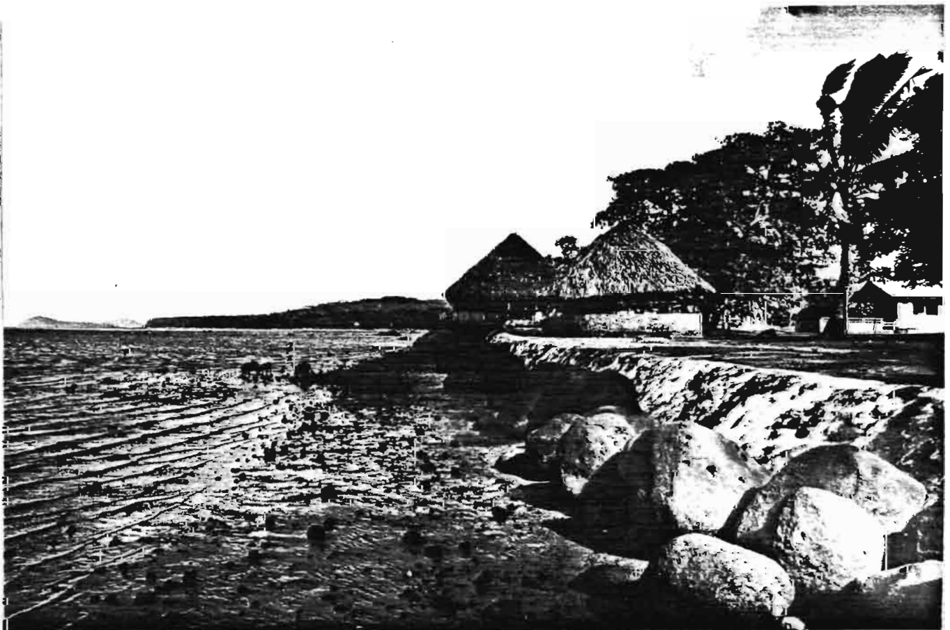
Habitat et constructions (Falés fono) en situation exposée, sur un remblaiement littoral légèrement protégé (mur, enro- chements) (VAITUPU-HIHIFO-UVEA)
