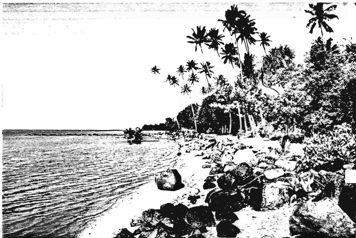
Enrochements de protection sur une côte basse, habitée au delà de la route (VAILALA-HIHIFO-UVEA)
