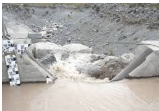
Figura 6.3. Foto del vertedero trapezoidal y regleta. Estación Los Crespos
