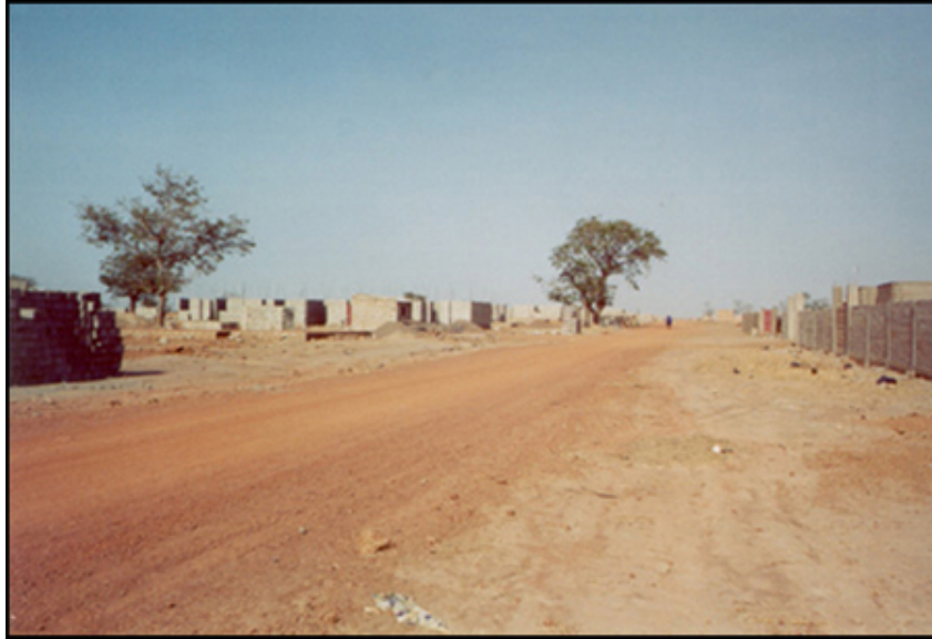
Photographie 11 : Une partie Ouest, en cours de lotissement
