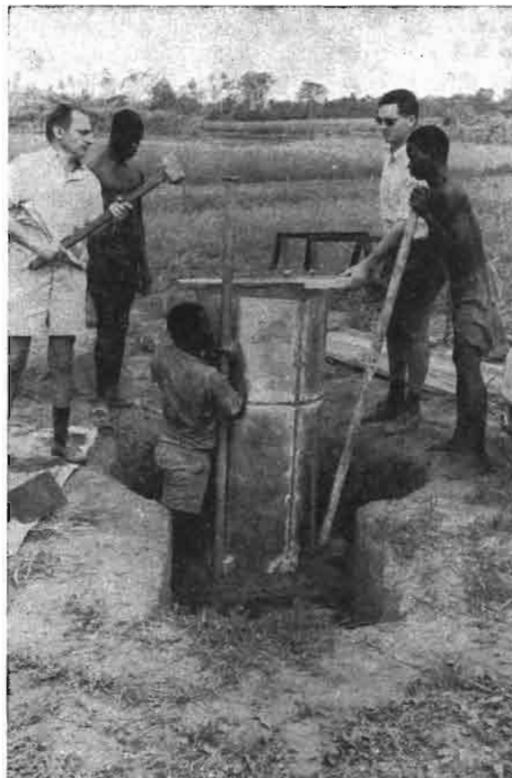
Fig. 5 et 6 — Mise en place d'une case de drainage sur monolithe.
