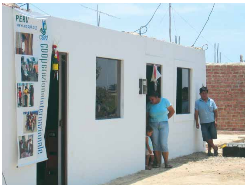
Figura 17 – Vivienda construida en Fundo Magdalena (distrito de Chincha Baja) con el apoyo de la ONG Cooperazione Internazionale (Coopi)
