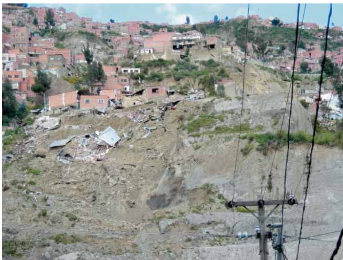
Figura 4 – El deslizamiento de tierra del barrio Retamani, Villa San Antonio, febrero de 2009, desencadenado por infiltración de aguas servidas en terrenos deleznales
