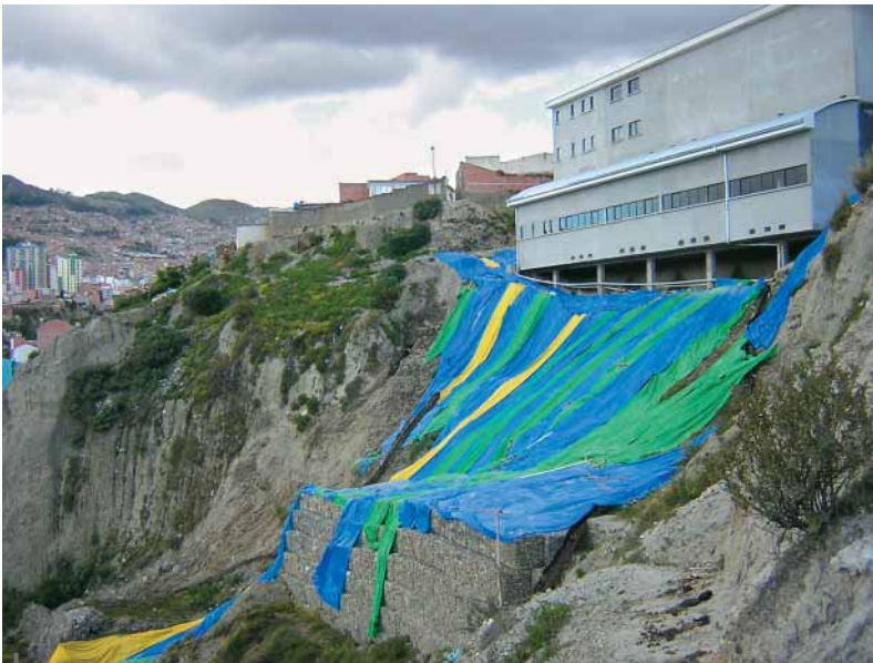
Figura 2 – Un complejo deportivo municipal se inauguró en 2006 en el macrodistrito San Antonio. Simboliza la decisión municipal de invertir en obras de infraestructura destinadas a volver atractiva a La Paz. Construido sobre un terreno inestable con fuerte declive, se dañó muy rápidamente, obligando a los gestores, para protegerlo de las amenazas, a construir obras defensivas cuyo costo ha sido más elevado que el del propio complejo
