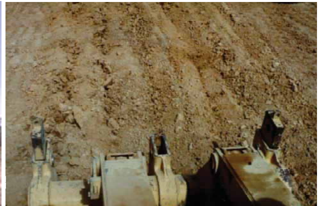
Photos 4a et 4b. Défonçage au bulldozer muni de 3 dents du tepetate , S.M. Tlaixpán, Mexique (Prat).
