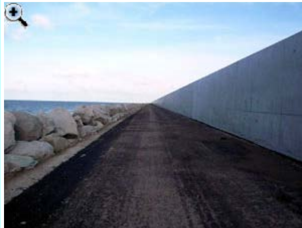
7. Mur bordant le port sur la plage Nord (cliché: E. Berson, 2009)
