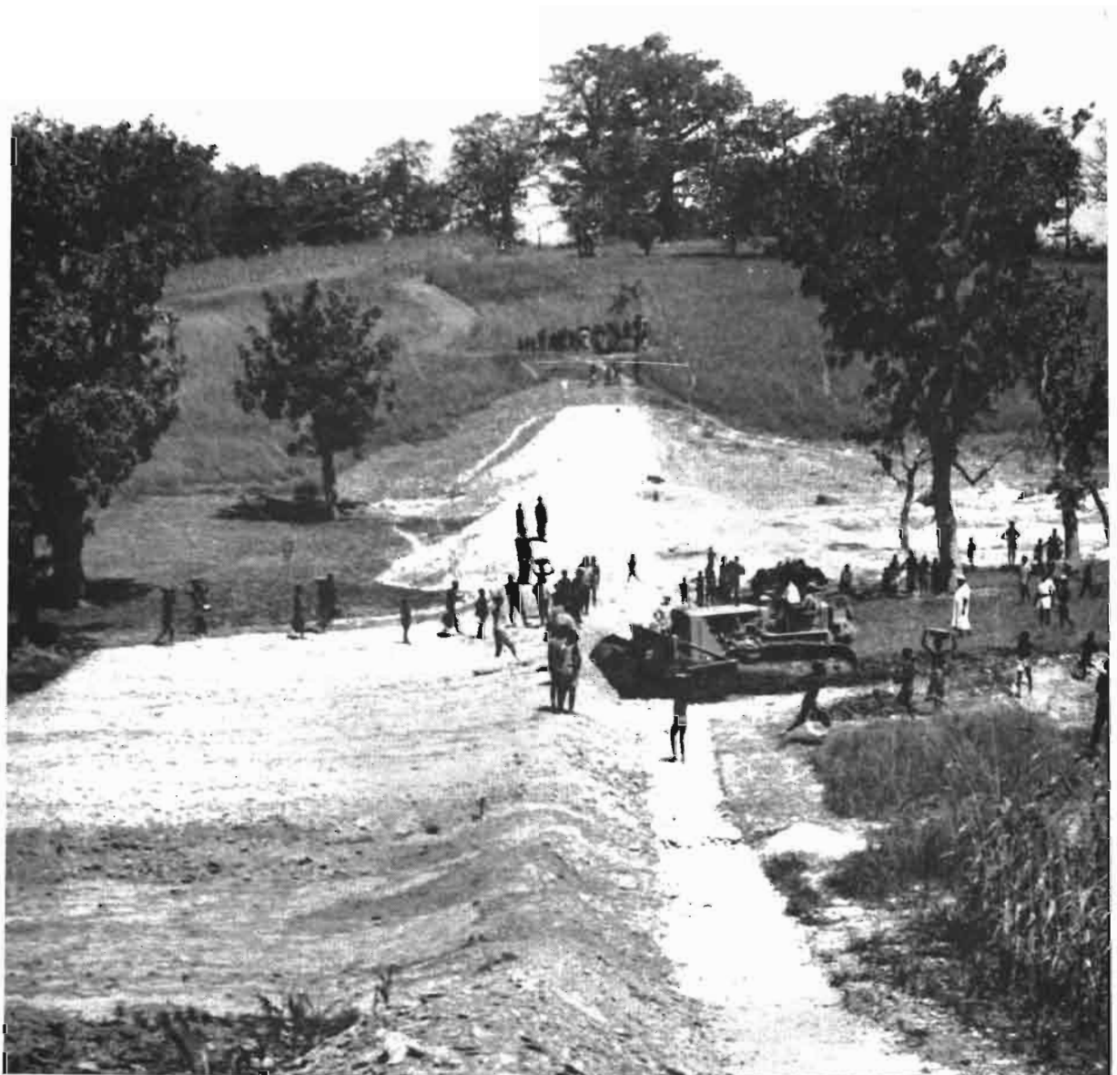
Restauration des sols au Togo : Semnord. Mais les travaux les plus populaires sont incontestablement les barrages de retenue d'eau construits en terre par le moyen du bulldozer
