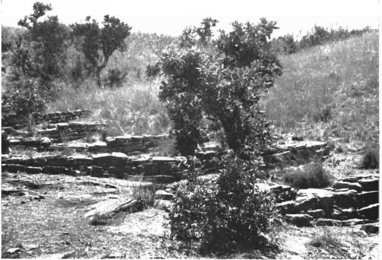
Restauration des sols au Togo : Semnord. Les premiers travaux de restauration des sols utilisaient des ouvrages simples et efficaces, tels ces petits barrages en pierres sèches édifiés dans le cours d'un marigol
