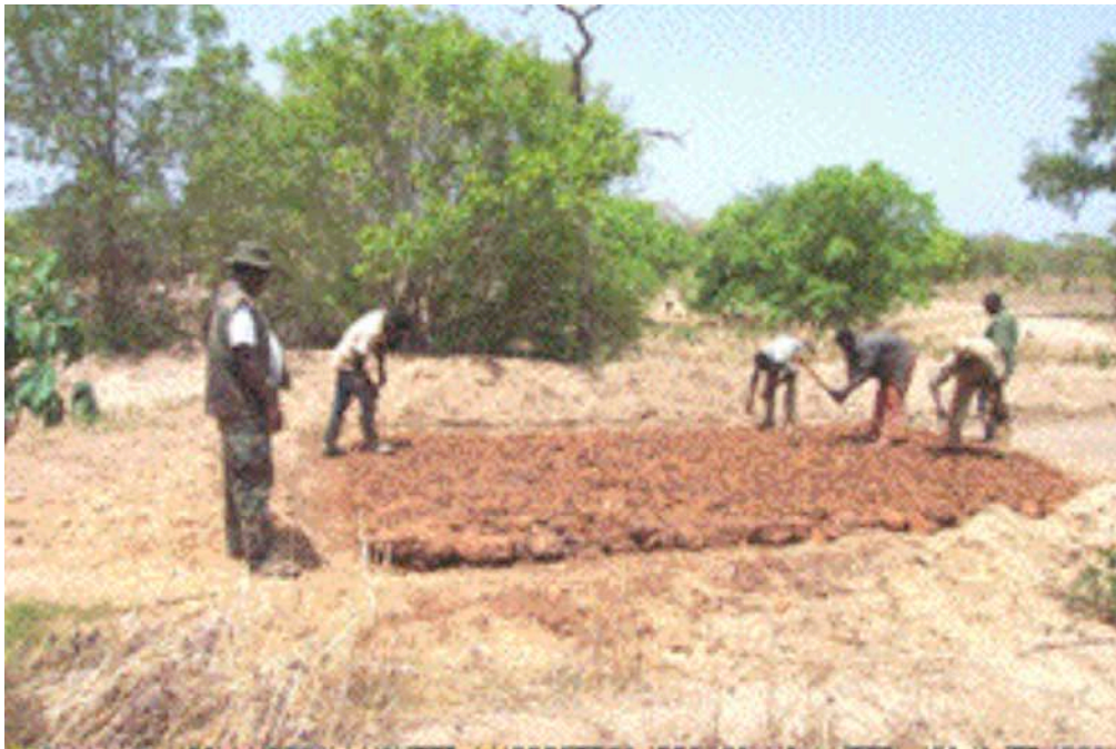
Photographie 4 : Membres des Avigref et agents du parc lors des travaux de pistes dans le parc (cliché El-Hadj Issa, 2003).
