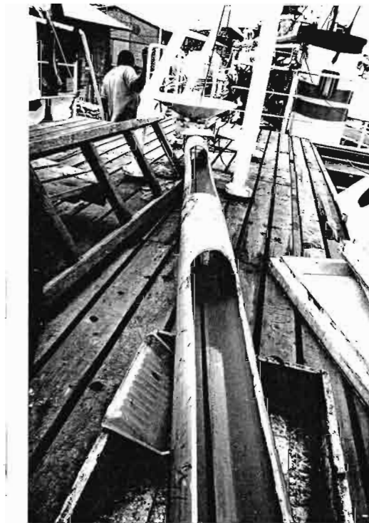
N° 13 - Tuyau PVC pour le guidage de la ligne.
