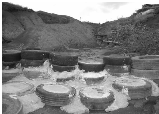
Figura 3. Control y estabilización de taludes de cárcavas (neumáticos encalados en primer plano; ensayos de reinstauración de vegetación al fondo y a la derecha).
