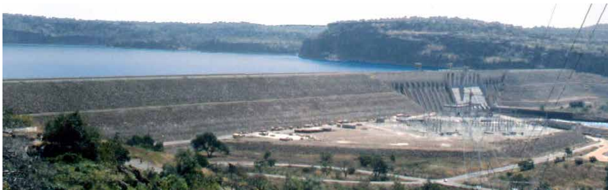
Figure 10. Barrage de Manantali
