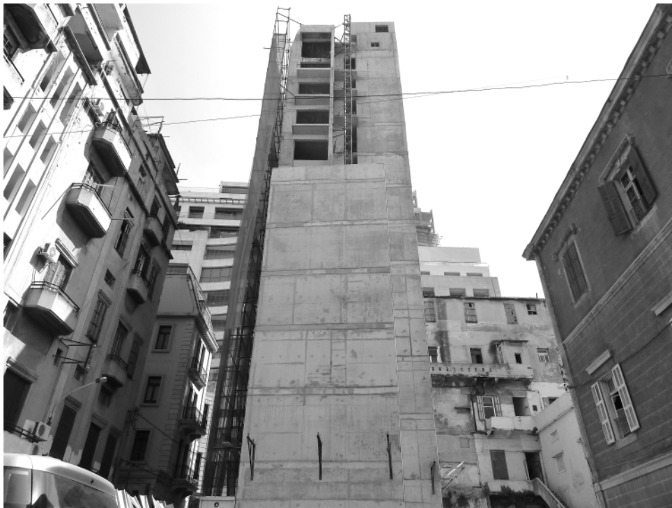
Photo 2 : Tour en construction au milieu d'immeubles anciens dans les quartiers péri-centraux de Beyrouth, ici à Gemayzeh ©Valérie Clerc 2012.
