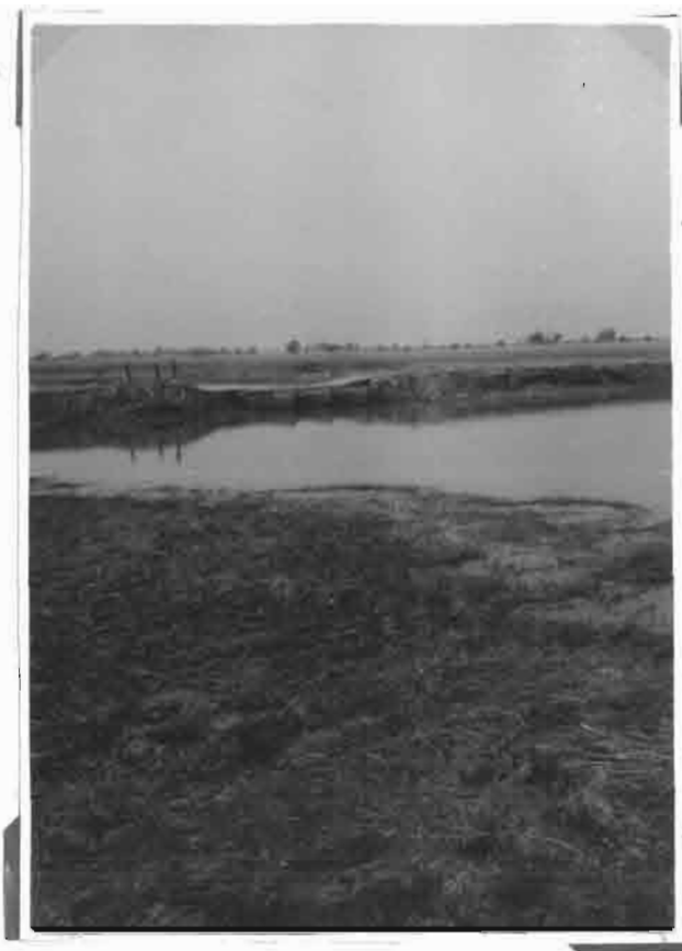
Fig. 1. - Digue - route, barant la Kabra, près de Tikeu
