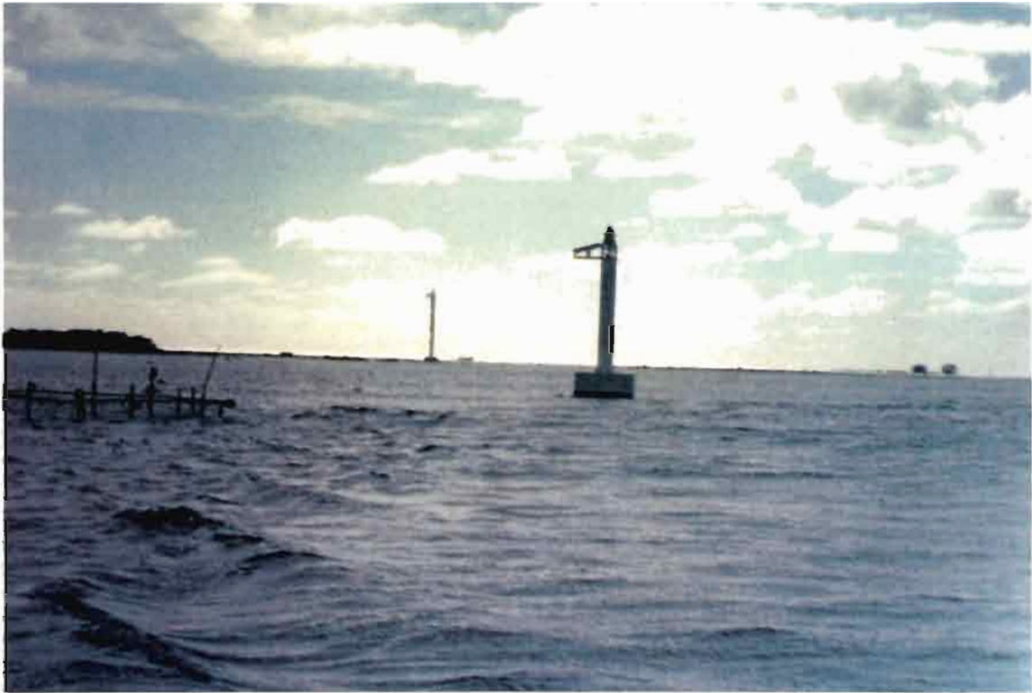
A7A : Vue des balises matérialisant la passe d'entrée d'Apataki (Tuamotu).
