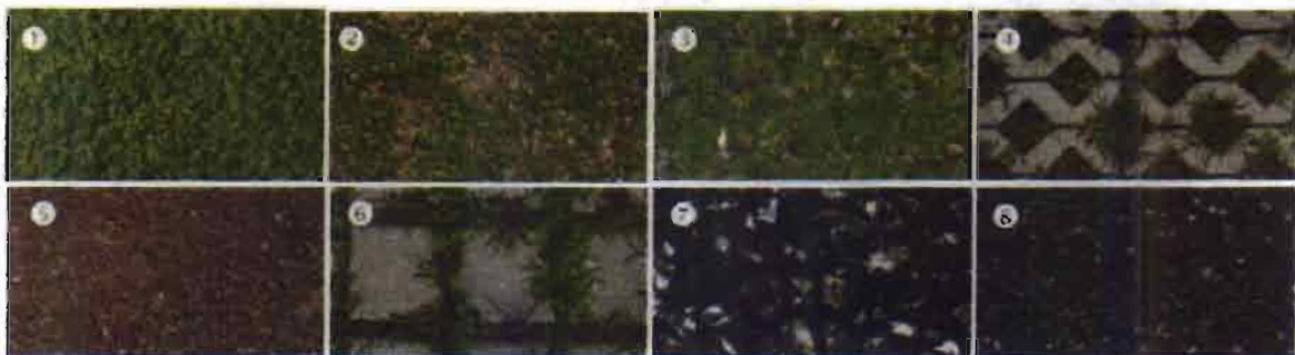
Fig. 7. Aperçu des surfaces urbaines les plus communes, de la plus à la moins perméable, comprenant (1) de la pelouse, (2) du gazon gravillonné, (3) des grilles en plastique enherbées, (4) des grilles en béton enherbées, (5) des allées empierrées (macadam), (6) des pavés en béton perméables, (7) de l'asphalte poreux et (8) de l'asphalte classique imperméable [13]
