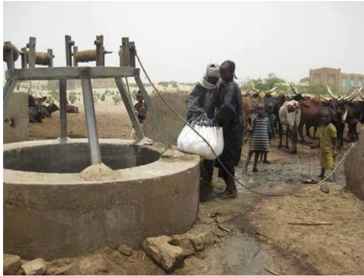
Figure 6 – Puits cimenté ouvert pour l’usage domestique et l’élevage (photo D. Djoret)
