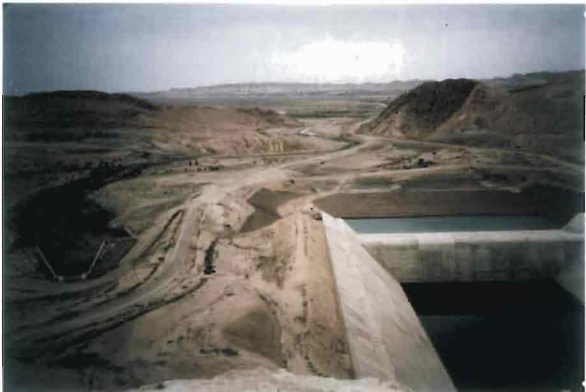
Le barrage de Sidi Saad, vue aval
