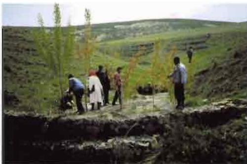
L'équipe « érosion » de l'Inref a comparé divers types de seuils aux gabions conventionnels. Ces derniers coûtent cher et doivent être soigneusement construits et fixés par la végétation pour éviter que se forment des « renards », tunnels sous le seuil qui remobilisent tous les sédiments et peuvent détruire le dispositif de proche en proche.
