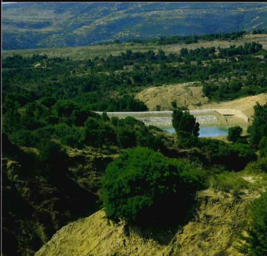
Vue plongeante sur lac collinaire avec protection arbustive Photo : H. Camus.
