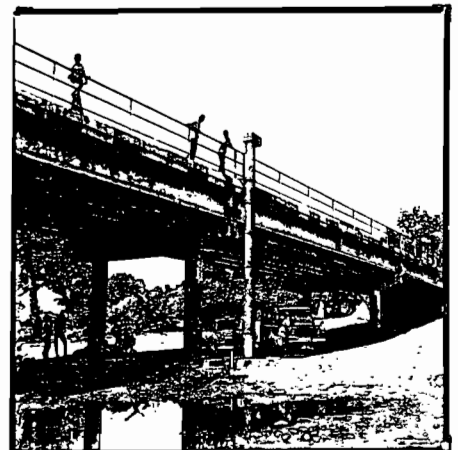
Installation limni- graphique de la CASA- MANCE à KOLDA.
