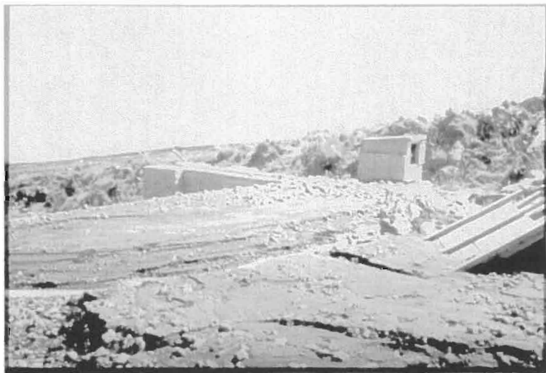
Photo 2 : vue du bassin de retenue et du canal, depuis l'amont
