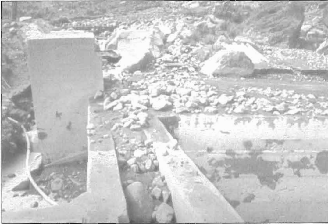
Photo 3 : vue du canal depuis l'aval
