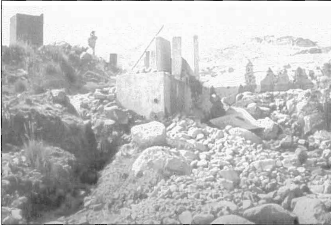
Photo 5 : vue de l'exutoire du canal depuis l'aval
