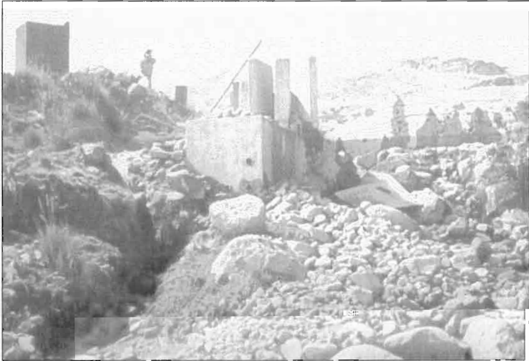
Photo 5 : vue de l'exutoire du canal depuis l'avul
