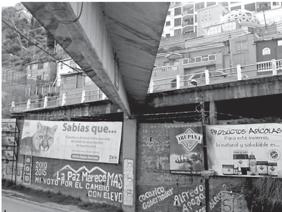
Figura 1 – Ejemplo de «torrentes» debajo de un puente en La Paz
